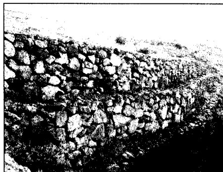
Photo.IV.2 : Illustration de l'incurvation et la déformation du mur de soutènement (prise en 2011).
