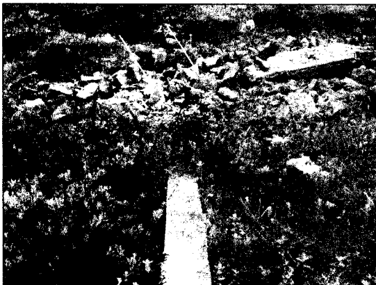
Photo.IV.5: Destruction du mur de soutènement (Importance des poussées), prise en 2011.
