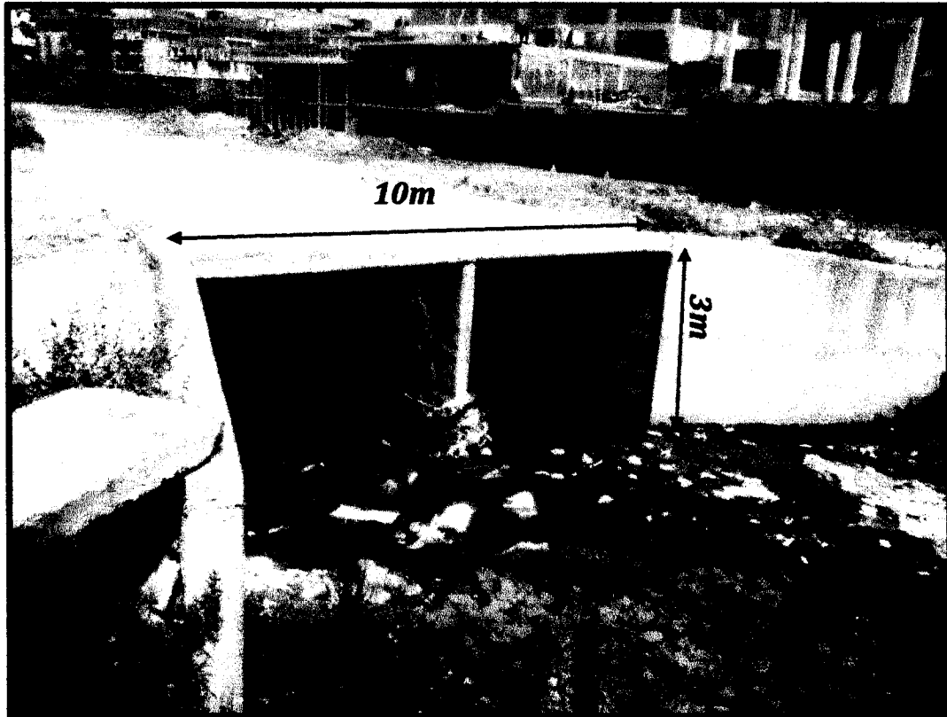
Figure n° IV-1 : Photo illustre le dimensionnement de canal de l'oued El-Kantara
