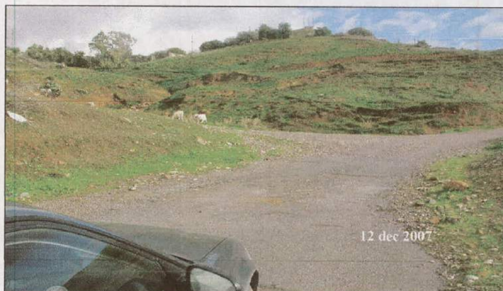
Figure 13 : glissements de terrain provoqués par le barrage
