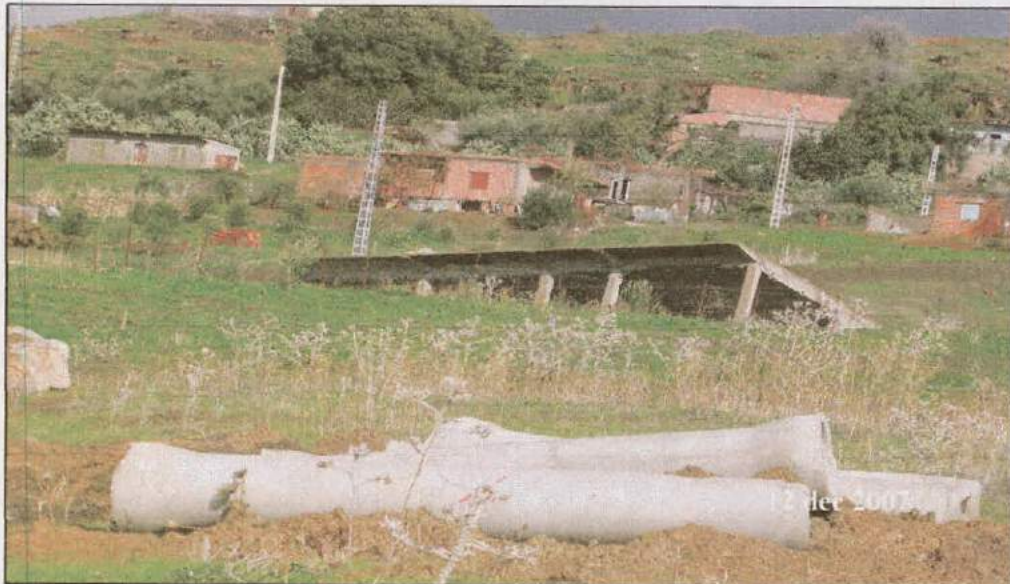
Figure 15 : maisons endommagées par le glissement de terrain.
