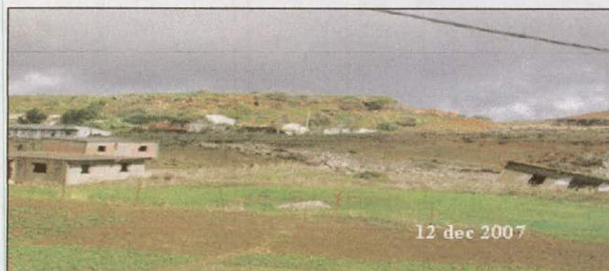
Figure 12 : conséquences géologiques de la mise en eau du barrage.
