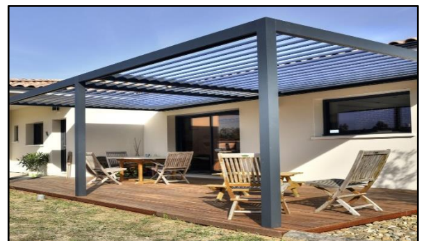
Figure 3-7 : Pergola : type de protection solaire
