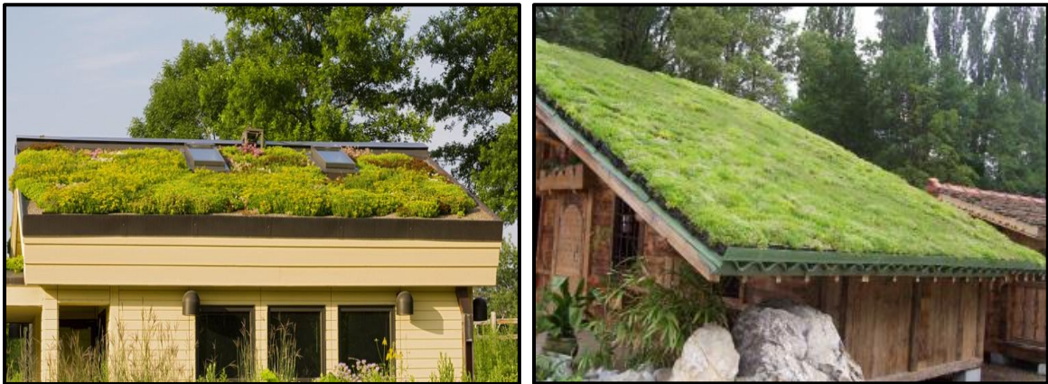
Figure 2-11 : Toiture végétale inclinée
