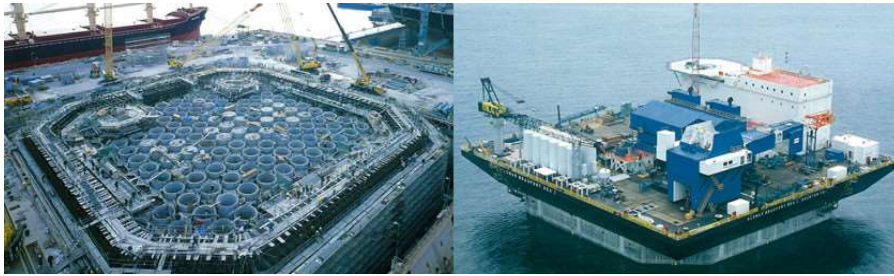
Fig 41 : les travaux de construction
