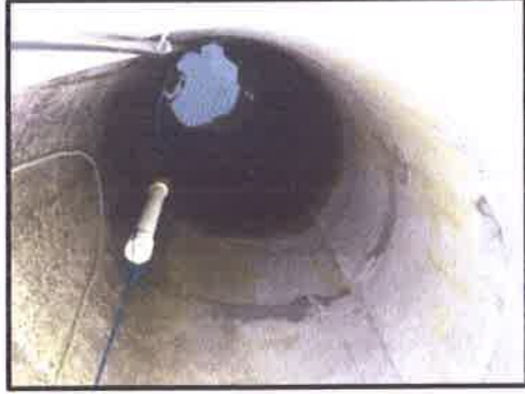
Figure 17. Prélèvement d'eau dans un puits.
