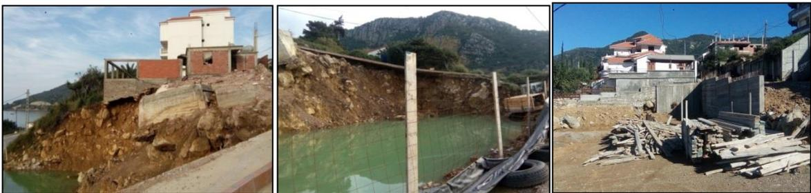
Figure 31 : Glissement du terrain dû au terrassement à l'AS des Aftis. Figure 32 : Travaux de terrassement
