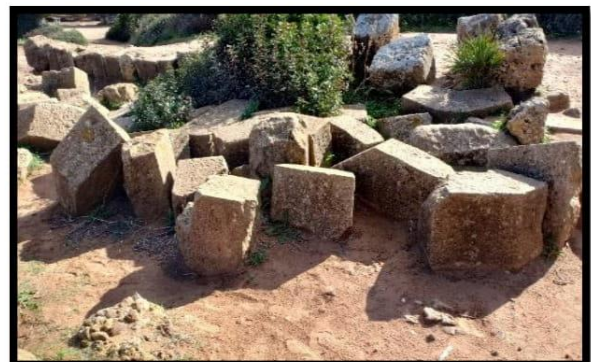
Figure 53 : Dégradation à cause de climat et végétation.
