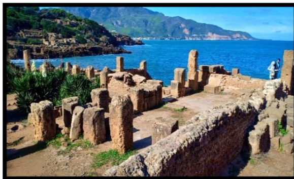
Figure 62: Les toitures et les couvertures en partie étudiée sont disparus.
