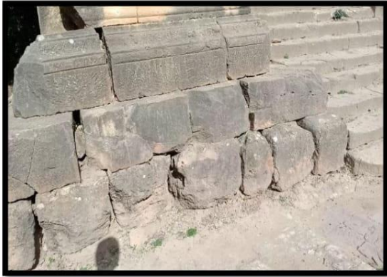
Figure 57: Des fissures et des lézardes très importantes sur les murs extérieurs
