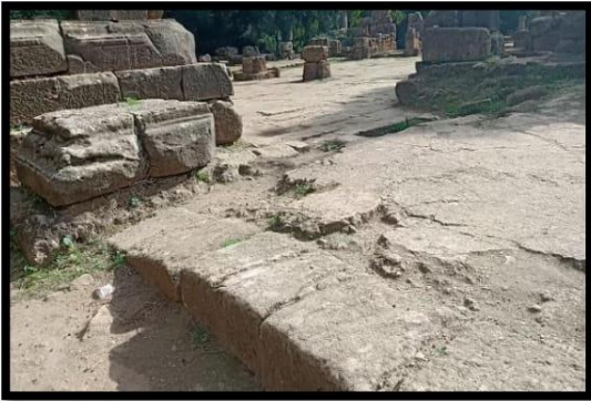
Figure 55: Dégradation à cause de climat et végétation.
