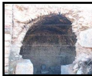
Figure n° III 23 : Destruction des structures des thermes du Capitole de Djemila
