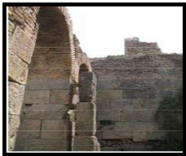
Figure n° III .20 : Décollement du pilier du sous-sol des grands thermes de Djemila
