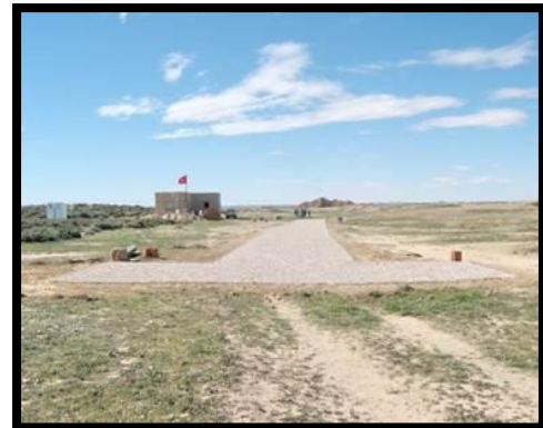
Figure n°I.08 : Début des travaux
