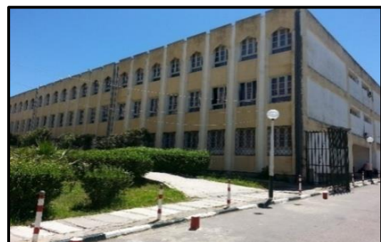
Photo 4-3 : façade nord -ouest de bloc 4. Source : Auteur
