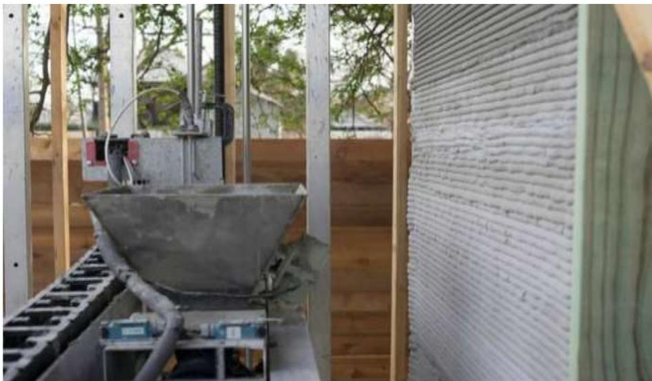
Photo IV.26: Les murs imprimé en béton
