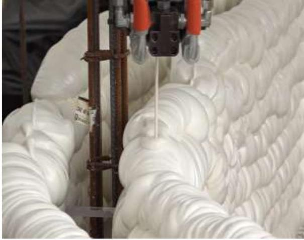
Photo IV. 16 : L'imprimante additive utilise du polyuréthane pour la construction de la maison Yhnova
