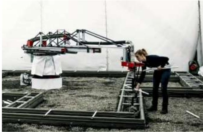
Photo III.4 : Installation manuelle de barres d'armature horizontales lors d'une impression 3D en béton
