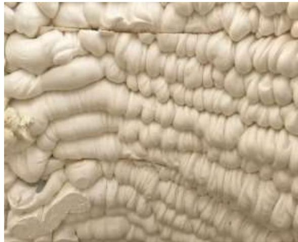
Photo IV. 17 : Un des murs en polyuréthane de la maison réalisé par l'imprimante
