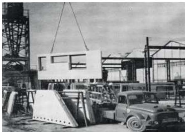
Photo I.1 : des éléments préfabriqués
