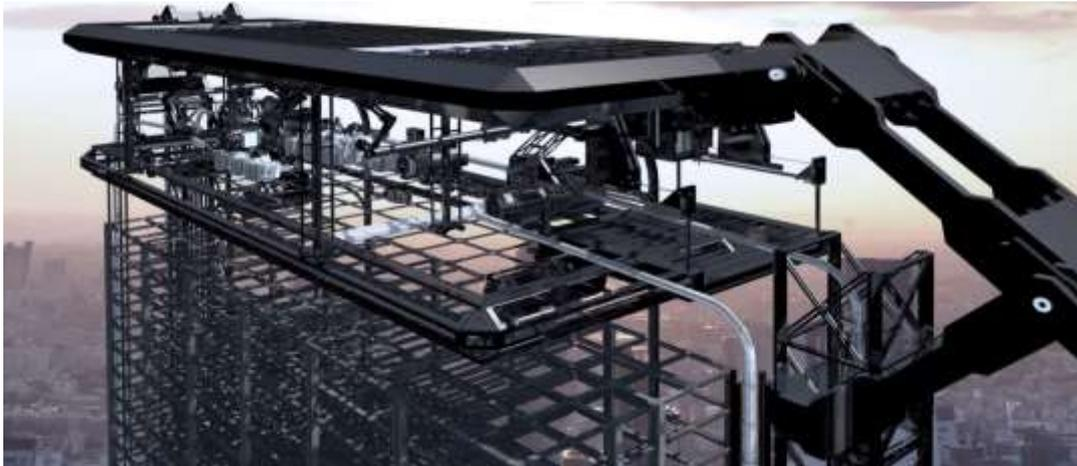
Photo IV. 31 : L'imprimante additive installée au sommet du gratte-ciel
