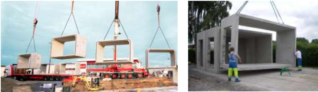
*Photo IV. 1 : Construction par système de préfabrication modulaire
