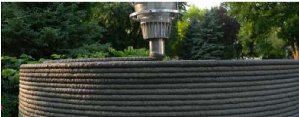
*Photo IV. 2 : Couches de béton imprimé en 3D
