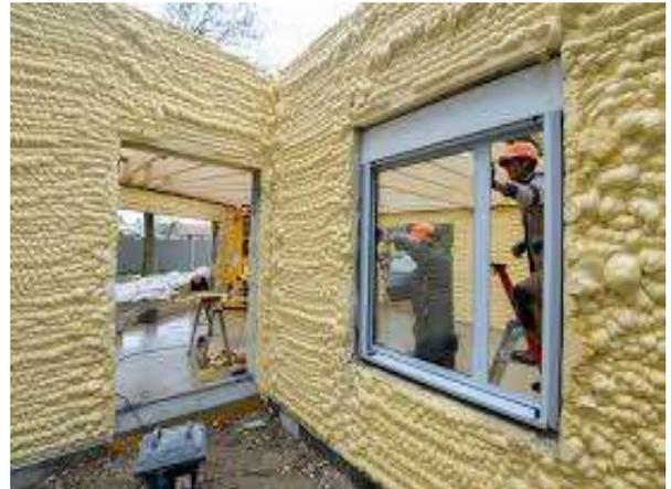
Photo IV. 21 : Mise en place des ouvertures
