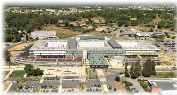
Figure 33: Centre hospitalier ales Cévennes France. Source : ch-ales consulté le 12/03/2019.
