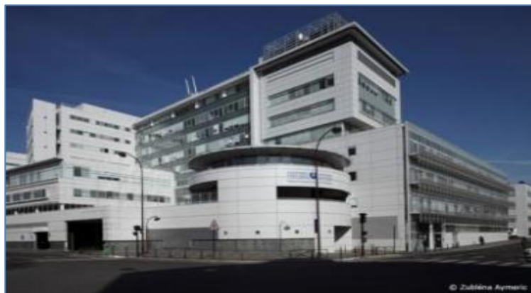
Figure 8 : Hôpital George Pompidou Source : Castelalu consulté le 08/02/2019.
