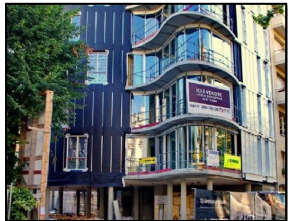
Photo N°35 : La technologie de la façade F4 de Saint-Gobain Source : www.batirama.com
