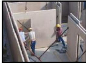
Photo N° 12 : Les cloisons de séparations Source : www.french.lightwei
