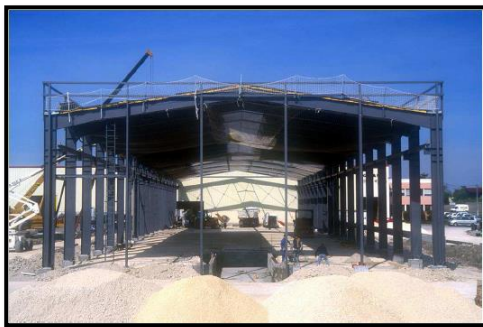
Photo N°18 : construction à portique métallique Source : www.ytong.f
