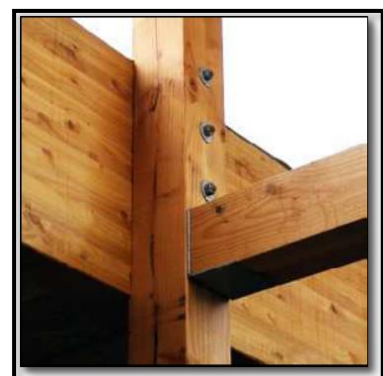
Photo N°22 : Exemple d'assemblage des poutres primaires sur les poteaux en bois. Source : www.certu.fr
