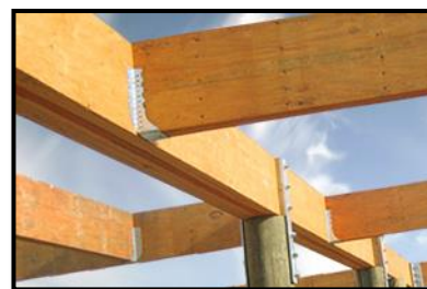
Photo N°30 : Structural Composite Lumber (SCL) Source : www.apawood.org.
