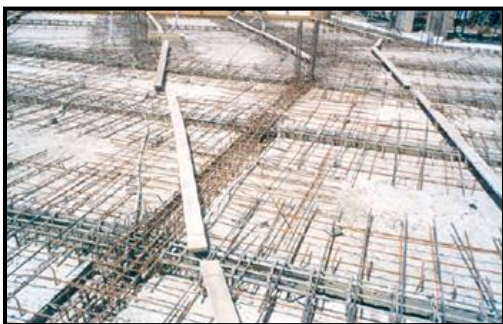
Photo N° 5 : Planchers complets de pièces d'habitation Source : www.uploads.gedimat.fr
