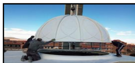
Photo N°43 : assemblage de coupole Source : www.tesproo.dz.com
