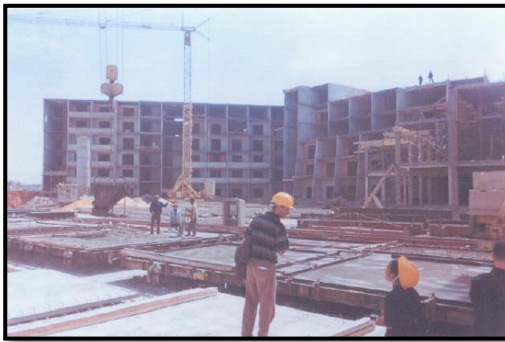
Photo N° 15 : Atelier précaire à l'air libre pied de l'ouvrage édifié Source : http://dgileblog.com
