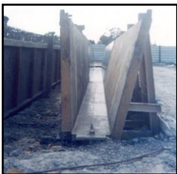
Photo N° 3 : Préfabriqués des gradins du stade de Bardo Préparation des aciers Source : www..academiepro.com
