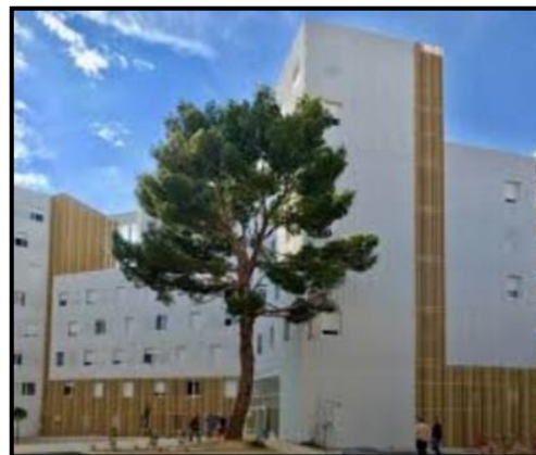
Photo N°38 : la résidence étudiante Lucien Cornil Source : Forum-holzbau préfabrication ou 3D : une nouvelle ré-sidence avec 200 logements dans la cité universitaire Lucien cornil à Marseille
