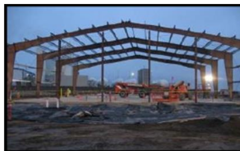
Photo N° 17 : Système portique. Source : https://www.cecobois.com .
