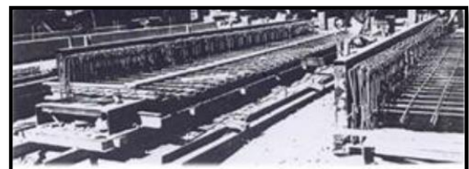
Photo N° 2 : Coffrage d'un élément stade de Radés Source : www..academiepro.com
