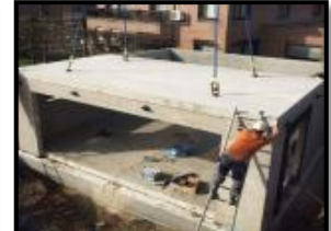
Photo N° 10 : Les planches Source : http://www.pyrenees-prefa.fr
