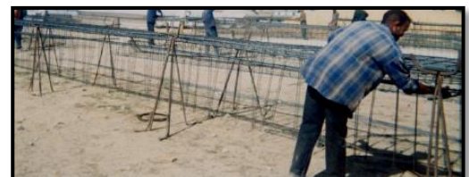
Photo N° 4 : Mise en place du ferrailage des éléments des éléments préfabriqués du Stade de Radés Source : www.academiepro.com
