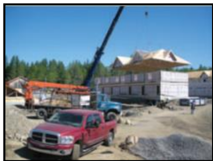
Photo N° 28 : Section de toiture Source : Guide technique sur la construction modulaire en bois
