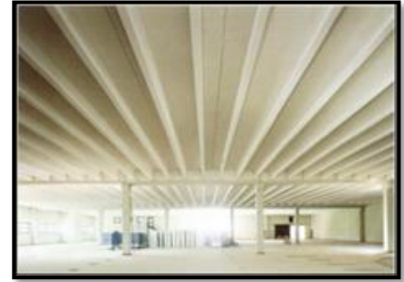
Photo N°24 : Exemple de plancher nervuré double T.
