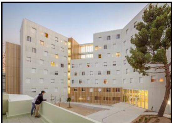
Photo N°37 : la résidence étudiante Lucien Cornil Source : Forum-holzbau préfabrication ou 3D : une nouvelle ré-sidence avec 200 logements dans la cité universitaire Lucien cornil à
