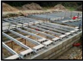
Photo N° 11 : Les poutrelles dimensions Source : french.lightweightwall panel
