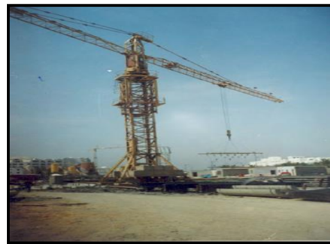
Photo N° 16 : emplacement des grues Source : w.dgileblog.com
