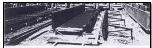
Photo N° 1 : Préparation des moules d'un élément de gradins préfabriqué -stade de Bardo Source : www.academiepro.com
