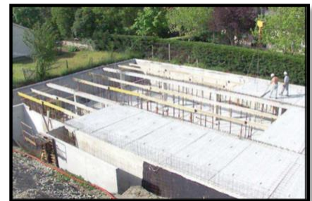
Photo N°25 : Exemple de plancher à prédalles.
