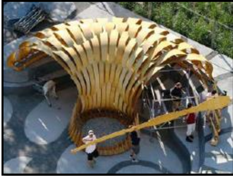
Photo N°33 : Montage du pavillon ICD /ITKE 2010 Source : www.apawood.org .
