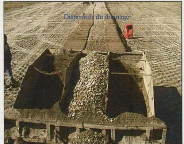
Photo VIII-02 : Dispositifs des filtres et du drain verticaux.
