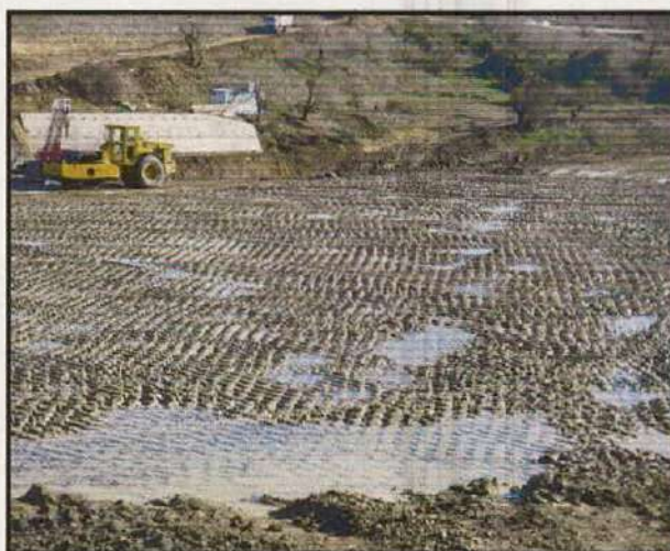
Photo VIII-01 : Lors du compactage du remblai.
