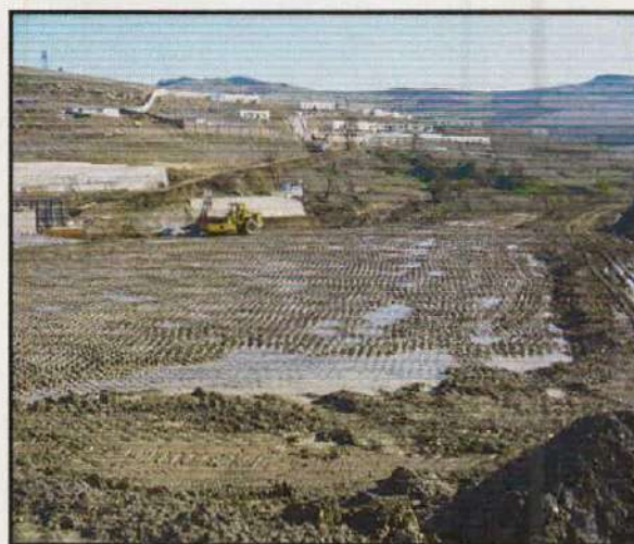
Photo VIII-01 : Lors du compactage du remblai.
