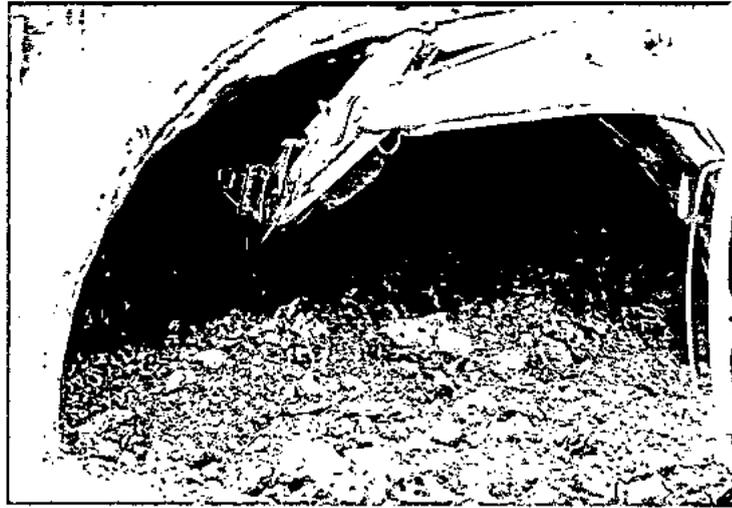
*Fig. VIII-5: Creusement à l'aide du brise roche*
