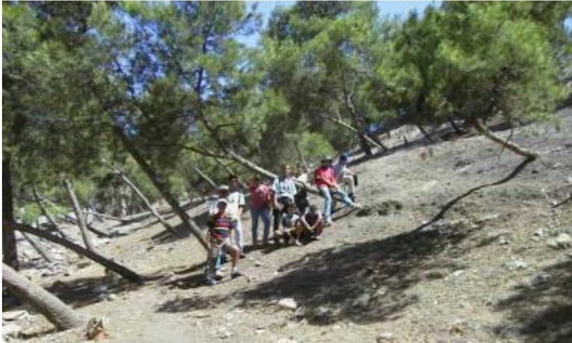
Photo.3 : Arbres inclinés montrant le glissement du Chemin Forestier et proche du pont de Sidi Rached (Machene 2002)
