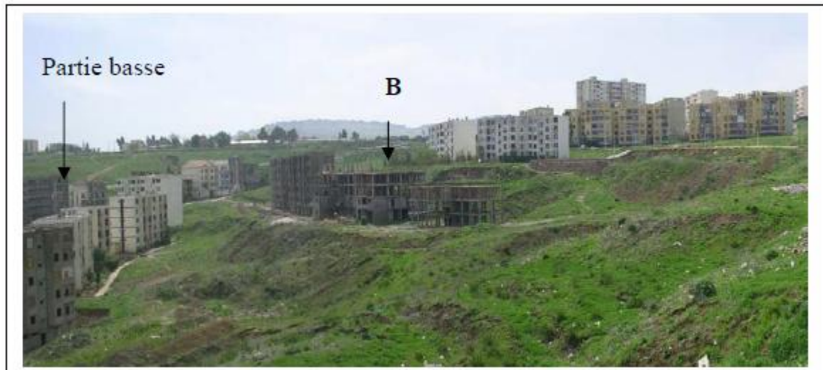
Photo.1 : Vue d'ensemble du site de Boussouf - talweg Ouest. La structure moutonnée des versants à gauche de la photo et derrière les immeubles est un signe clair d'instabilité (EEG SIMECSOL 2003)
