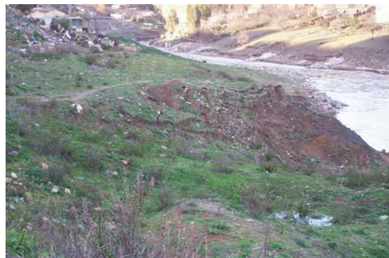
photo.4 : Photos de la route fissurée, affaissée et son talus aval instable du Bardo (Bougdal.R, 2007)
