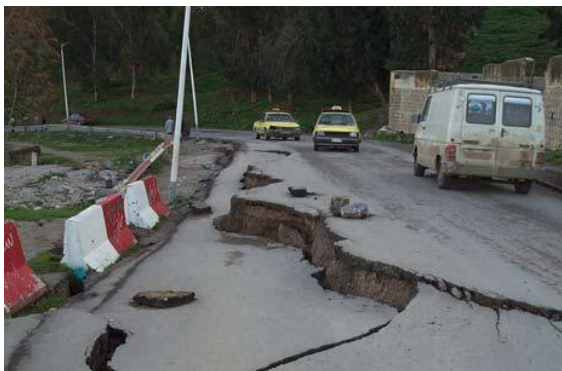
photo.4 : Photos de la route fissurée, affaissée et son talus aval instable du Bardo (Bougdal.R, 2007)
