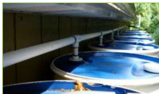
Image 6 : le système de récupération d'eau de pluie : la distribution, (Source : www.googel image.com)
