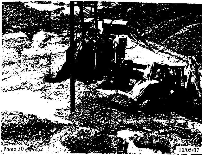
Photo 30 : La profondeur atteinte le rétrochargeur alimente le trou en matériaux d'apport (Ballast), site de Kissir
