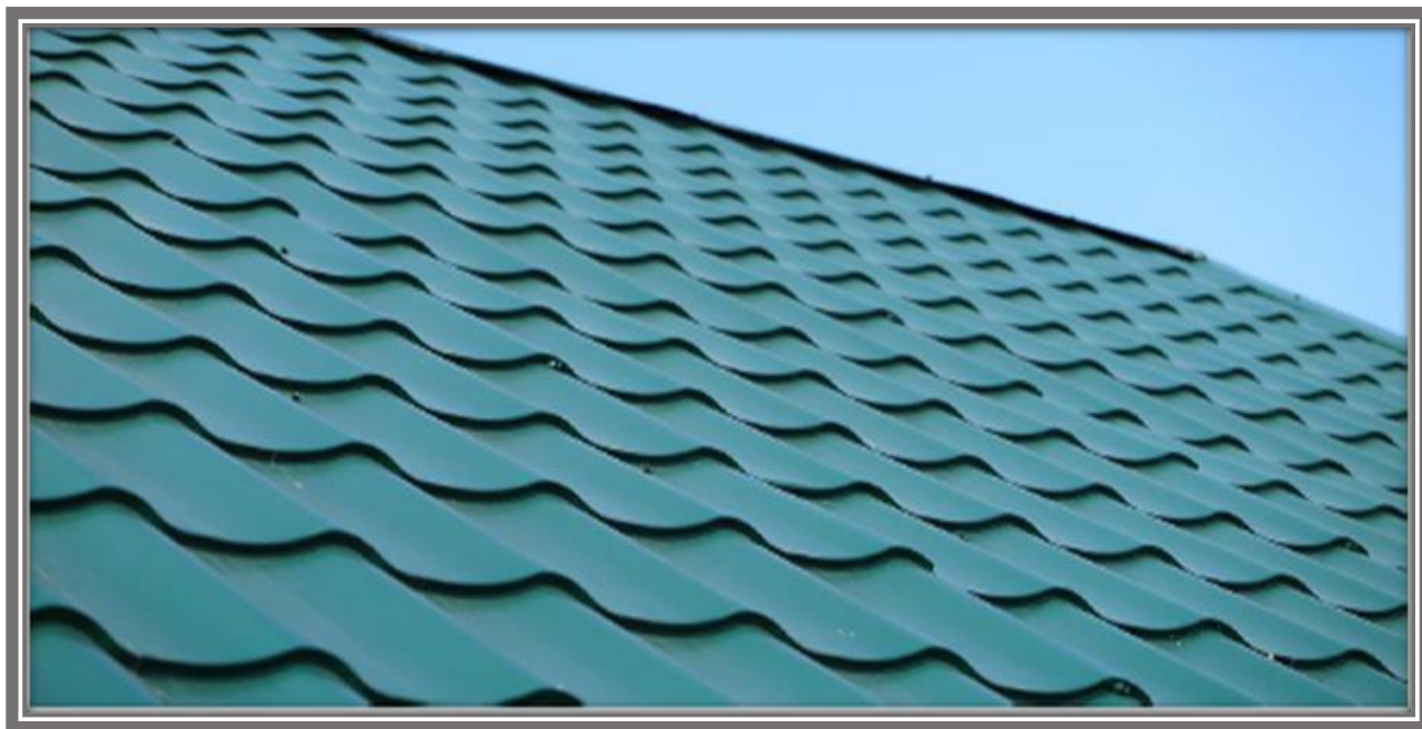
Figure 25:photo de toiture en tuile Source : Zeghdoudi Abdellatif Haouam Akrem mémoire master 2
