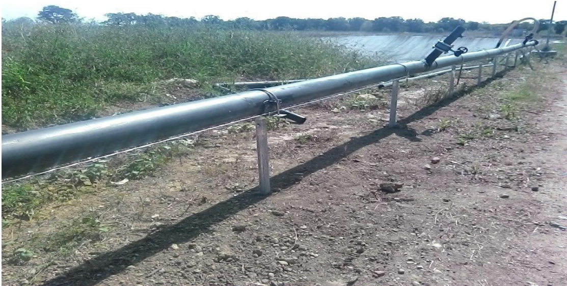
Fig.3.4: Installation d'un Réseau de biogaz
