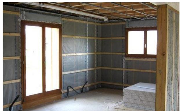
Figure 33: Isolation Thermique par Intérieur
