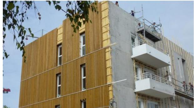
Figure 34: Les systèmes d'isolation par l'extérieur
