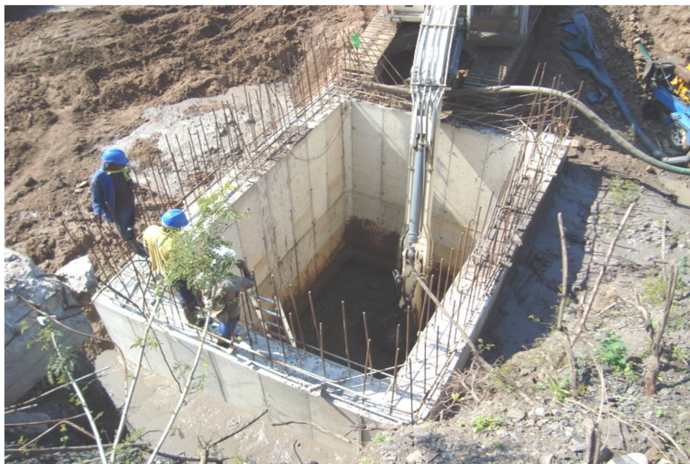
Figure 2.8. Fondation en caisson a 8 m de profondeur
