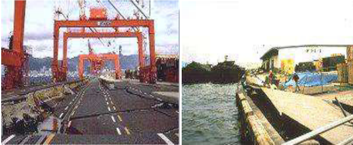
Figure I-12 Glissement de murs de quai : Lorsque le sol derrière et/ou sous un tel mur se liquéfie, la pression qu'il exerce sur le mur augmente considérablement et fait glisser ou/et incliner celui-ci.
