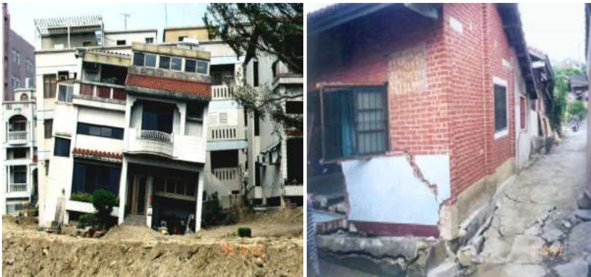
Figure I-18 Endommagement de bâtisses dû à la liquéfaction en Taiwan
