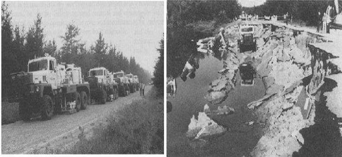
Figure 1-8 Rupture de remblai sur le lac Ackermann déclenché par camions de vibro-seisme
