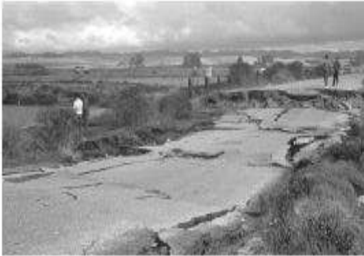
Figure I-10 Epandage latéral le long de la route Sandholdt ,(à gauche) et destruction d'un centre de recherche (à droite) à Moss Landing
