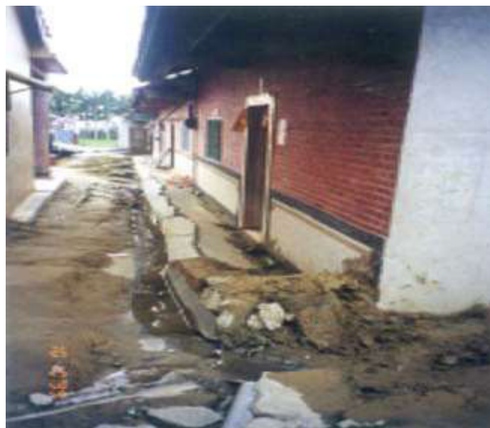
Figure I-16 Ebullition de sable dans un quartier résidentiel au Comté de Zhanghua
