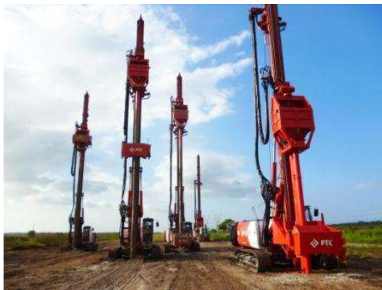
Figure I-27 les colonnes ballastées
