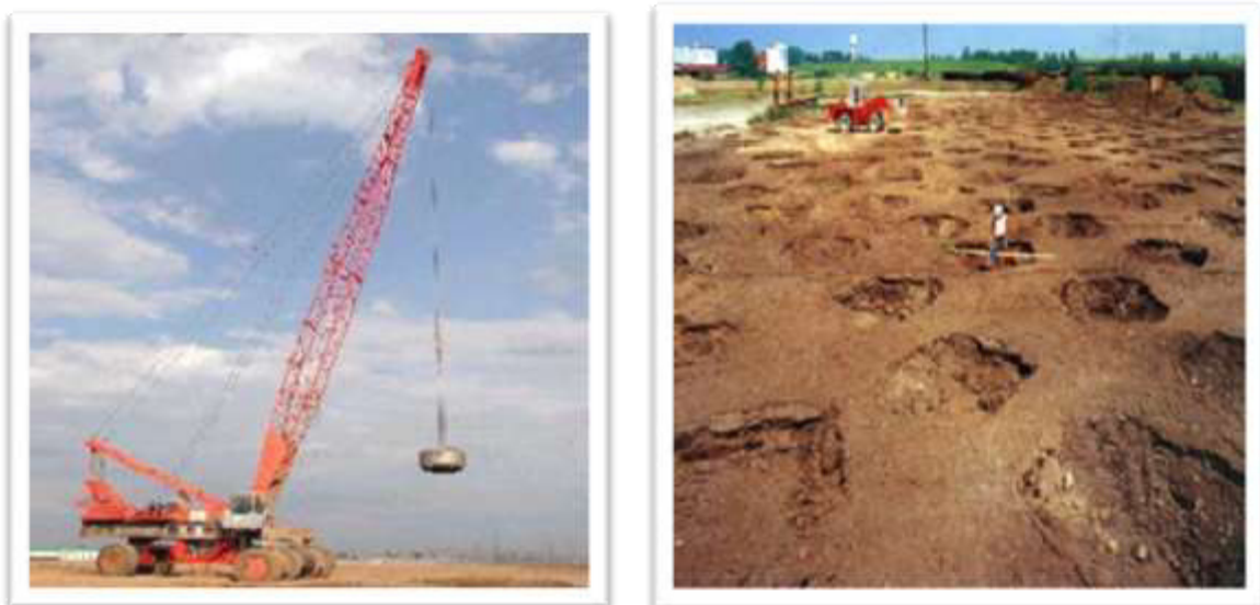
Figure I-30 compactage dynamique
