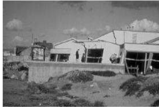
Figure I-10 Epandage latéral le long de la route Sandholdt ,(à gauche) et destruction d'un centre de recherche (à droite) à Moss Landing
