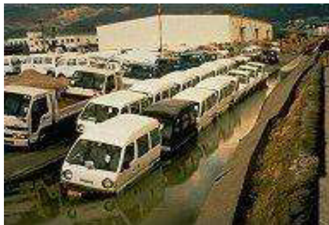
Figure I-14 Endommagement des routes : Baisse du niveau de la route due à l'épandage latéral.
