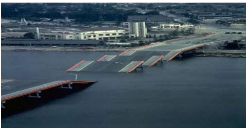
Figure I-7 Rupture du pont de Showa, à Niigata au Japon, dues à l'épandage latéral dans le sol [6]
