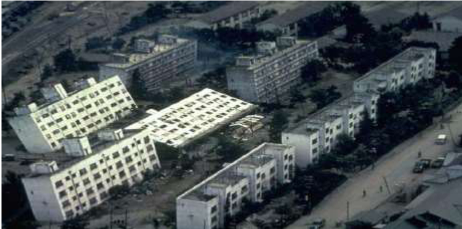
Figure I-6 Inclinaison des bâtiments d'appartements de Kawagishi-cho à Niigata au Japon dues à la chute de la capacité portante du sol par liquéfaction [6]
