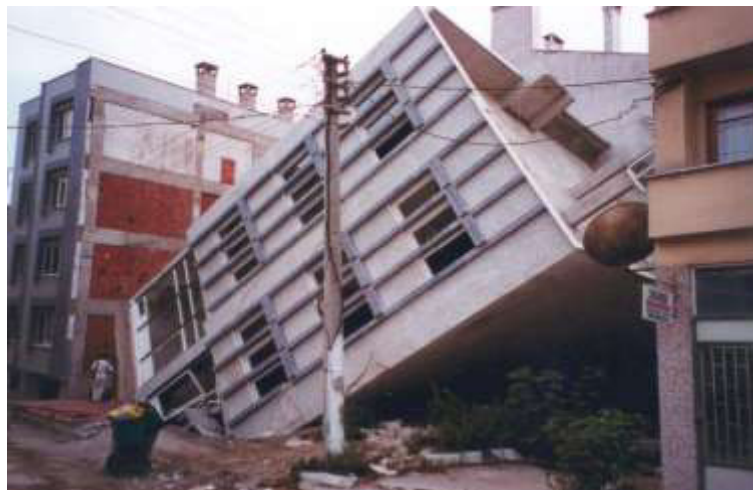
Figure I-20 Renversement d'une structure sous l'effet de la liquéfaction séisme Turquie 1999
