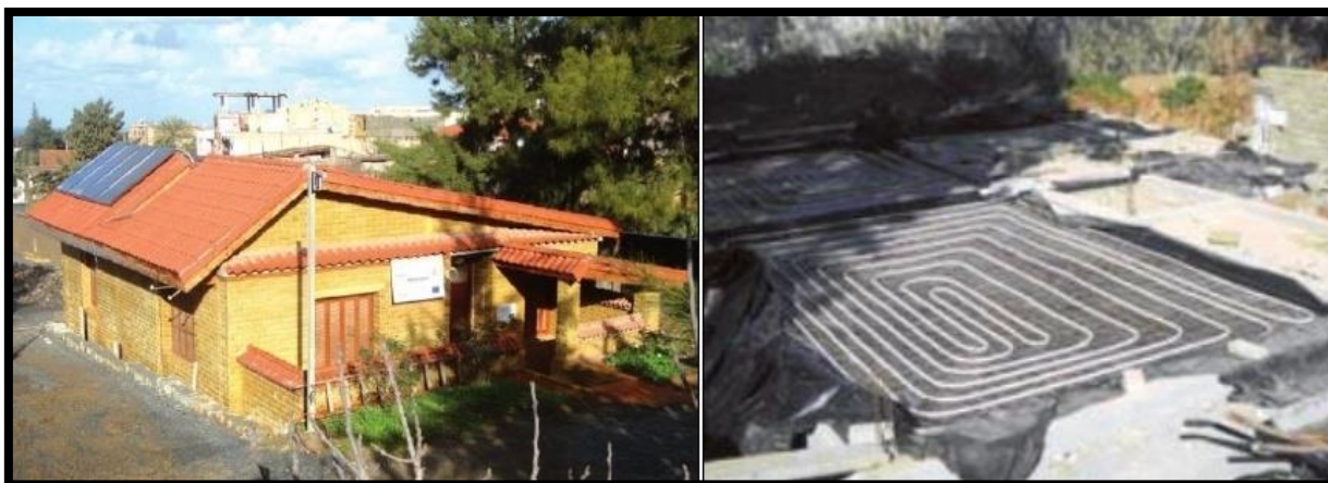
Figure 3: Projet pilote Med-Enec. Source: En ligne: « http://portail.cder.dz/spip.php?article2939 » (Consulté le : 25/09/2017)
