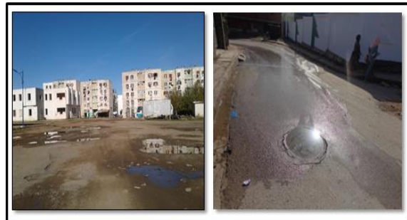
Photo 4: Absence de gestion des eaux pluviales.
