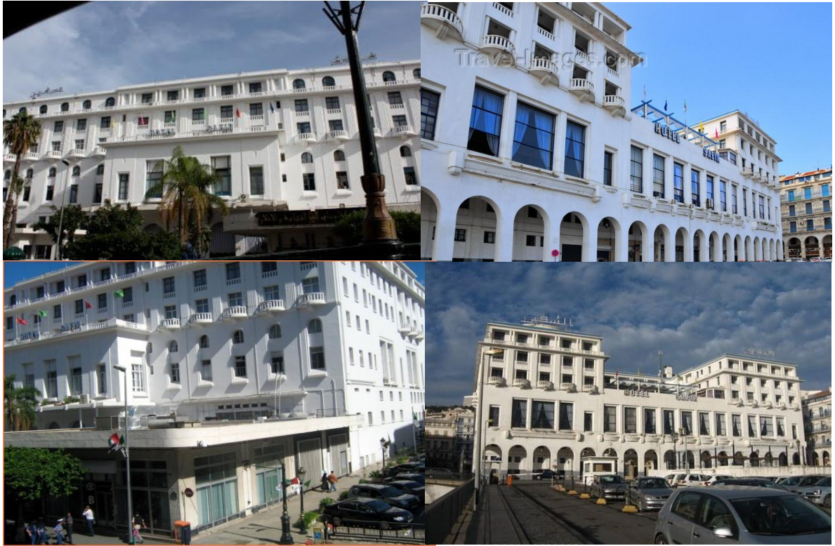
Fig.138 : Façades et environnement extérieur de l'hôtel Es-Safir
