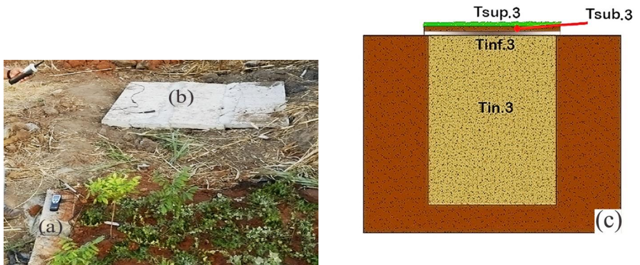
FIGURE 5.13 : Module expérimental avec dalle en béton armé, (a) recouvert de végétation extensive, (b) module de référence (c) coupe verticale
