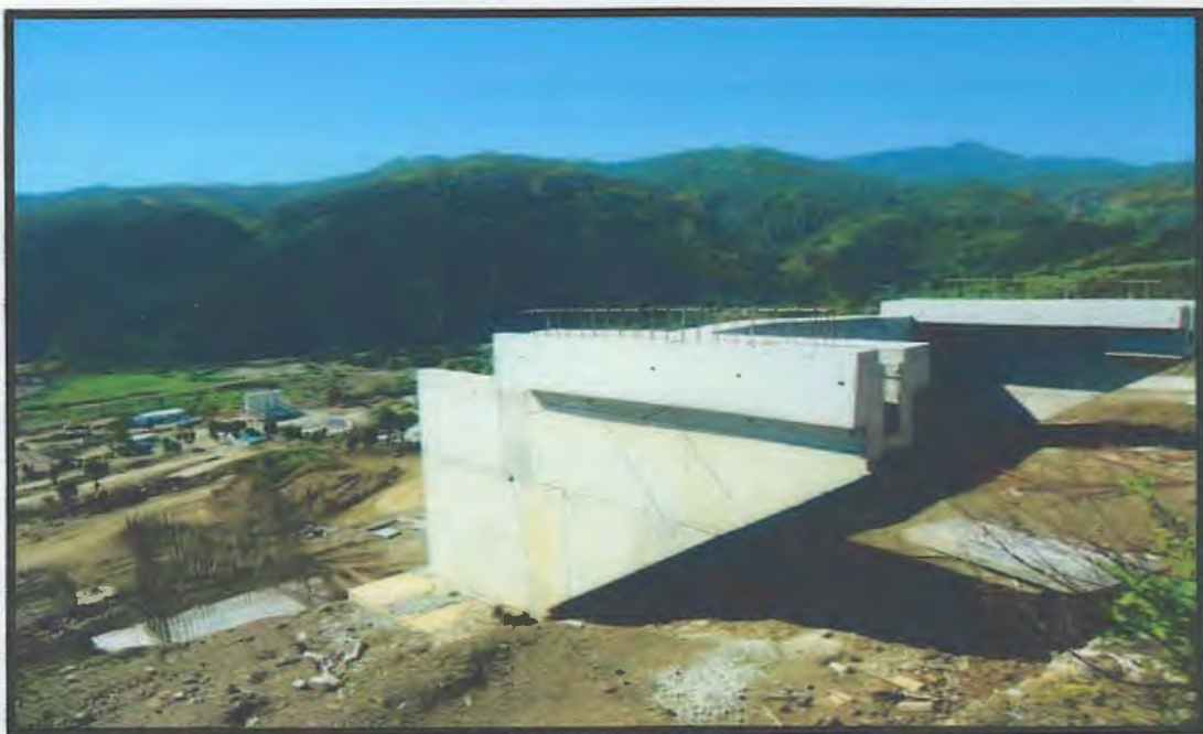
Photo .II.1 : Culée reposant sur le flysch Albo-Aptien.
