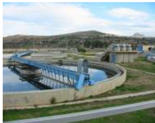
Bassins de décantation
