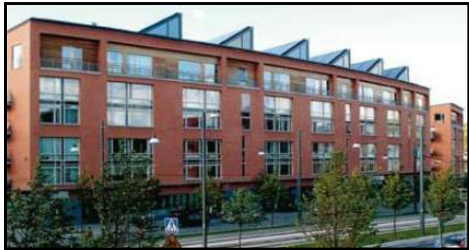
Figure 8 : Photos des capteurs solaires placés sur le toit des bâtiments.
