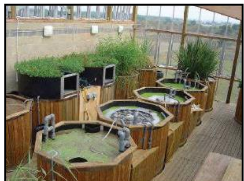
Figure 34: Photos des bassins de traitement naturel d'eau.
