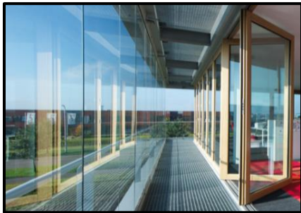
Figure 22 : Photos d'une façade double peau "intérieure"
