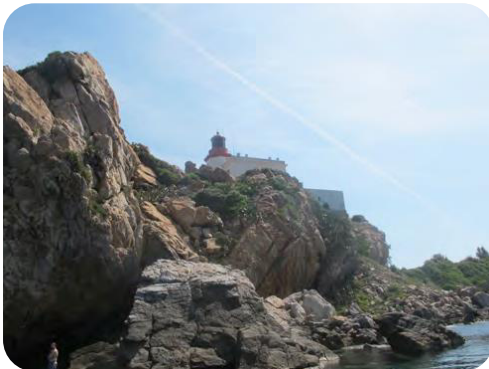
Figure 36: Falaises en bordure de la baie du Grand Phare
