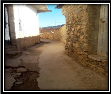
Photo n°22: La rue secondaire.
