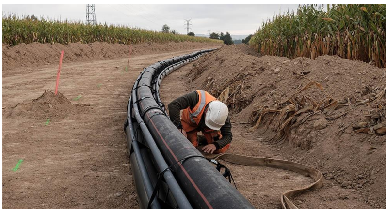
Figure I.3. Ligne de transmission souterraine.
