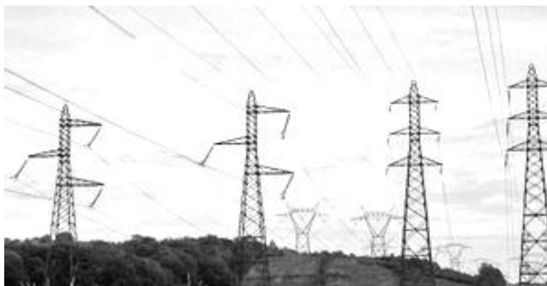
Figure I.2. Vue générale d'une partie d'un réseau de lignes aériennes.
