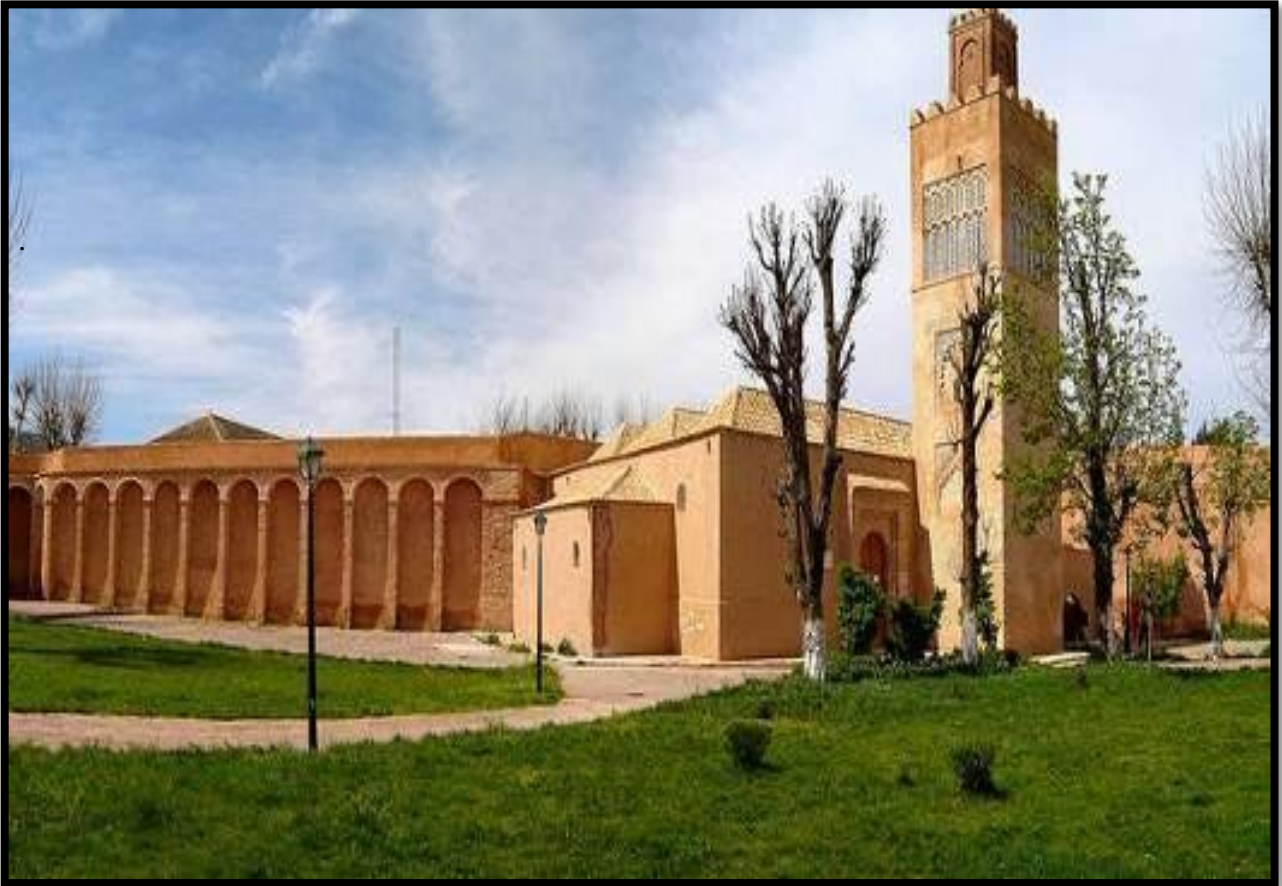
Figure 31 : vue sur la mosquée et rempart intérieur après la restauration
