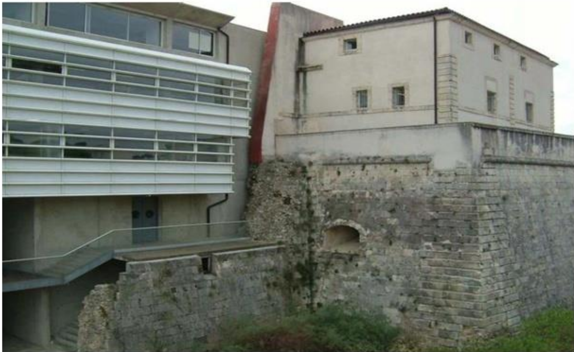
Figure 18 : Vue sur la bibliothèque.
