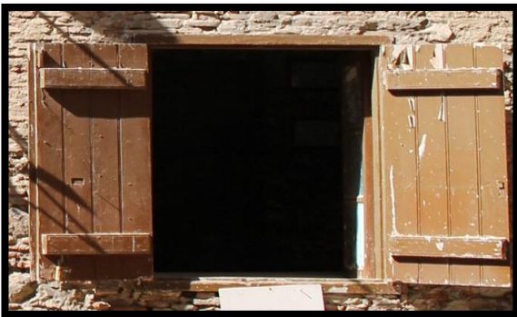
Figure 51 : les fenêtres en bois
