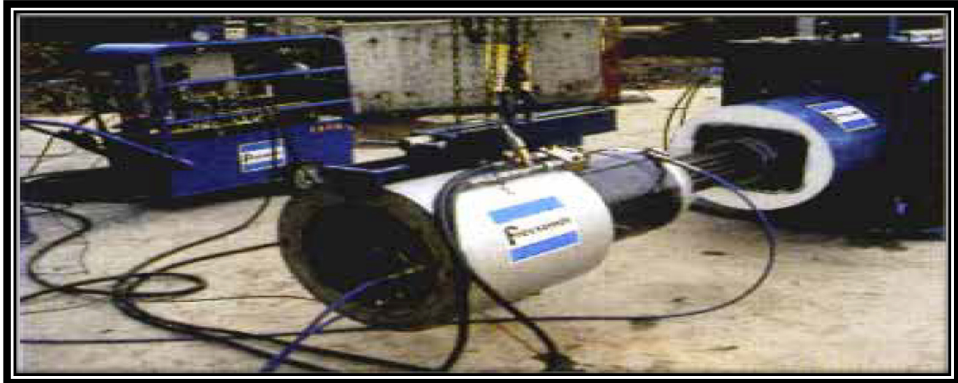
Figure VII.2 : Mise en tension des câbles
