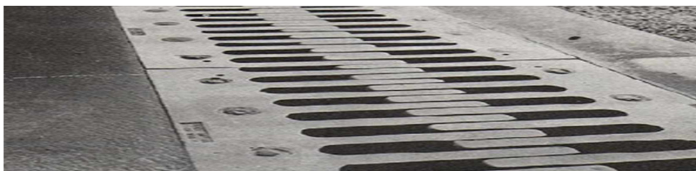
Figure .X.2 : Joint de chaussée
