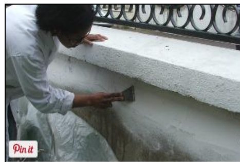
Étape 6 : Après un temps de séchage de 2 heures, passer le riflard de maçon, afin d'égrener les parties d'enduits non adhérentes.
