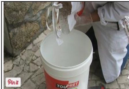
Étape 3 : Préparer l'enduit de rebouchage extérieur.
