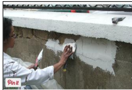
Étape 4 : Appliquer l'enduit.
