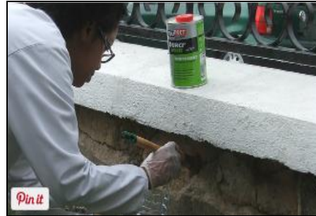
Étape 2 : Appliquer à la brosse de pouce un durcisseur de mur friable sur l'ensemble de la partie endommagée.
