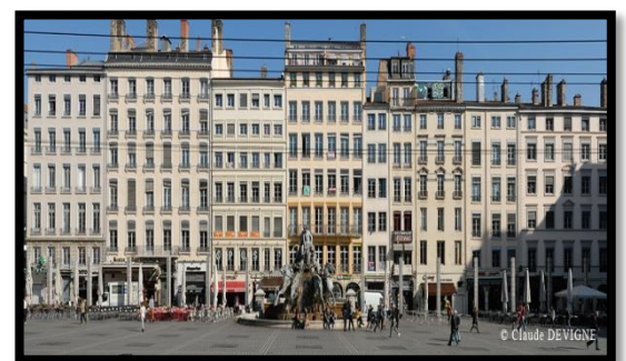
Figure N°22 :La place des Terreaux.
