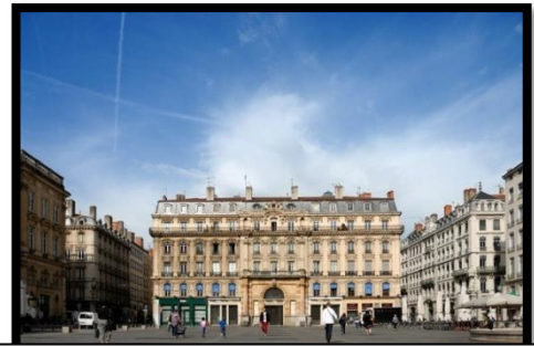
Figure N°28 :le Palais Saint-Pierre
