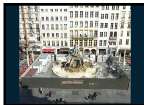
Figure N°31 : Le chantier sur la fontaine
