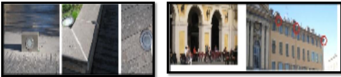
Figures N°47,48 : Les luminaires sur les façades et au sol
