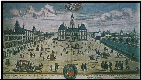
Figure N°25 :La place des Terreaux
