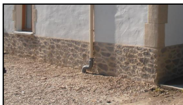
Photo 60 : le traitement des soubassements.
