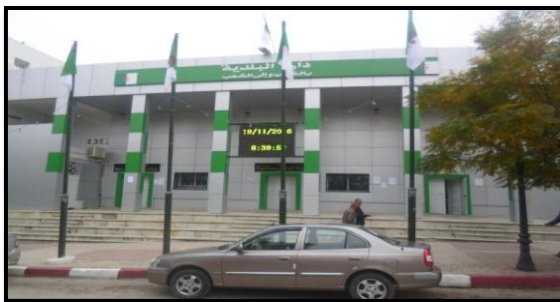
photo 10 : de la façade du siège de l'APC Mila
