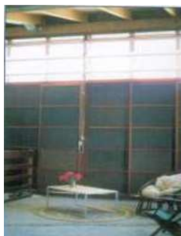
Figure. IV .2 : Utilisation des volets intérieurs pour le captage et la protection solaire. Source : Mimi Tjoja architecte.
