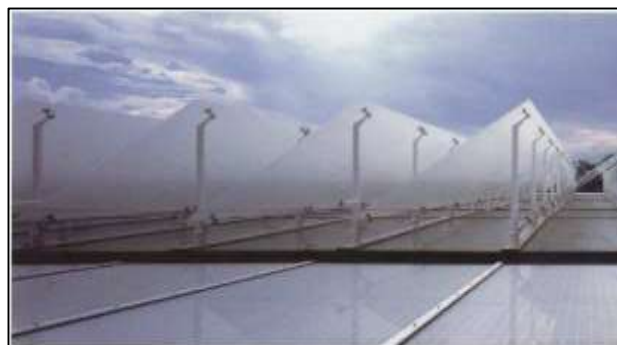
Figure IV. 9 : Protection solaire extérieure par des panneaux de verre émaillés et inclinés Source : ROBERTO GONZALO
