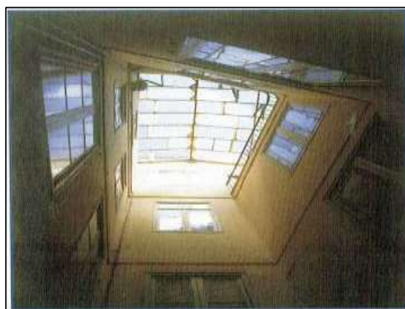
Figure IV.5 : Verrière sur une cour intérieure ouverte à l'origine, à Perpignan.
