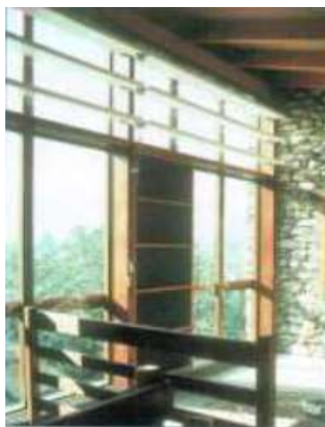
Figure. IV .2 : Utilisation des volets intérieurs pour le captage et la protection solaire. Source : Mimi Tjoja architecte.
