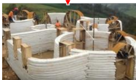
Image 43 : Emplacement des moules des ouvertures en bois performant
