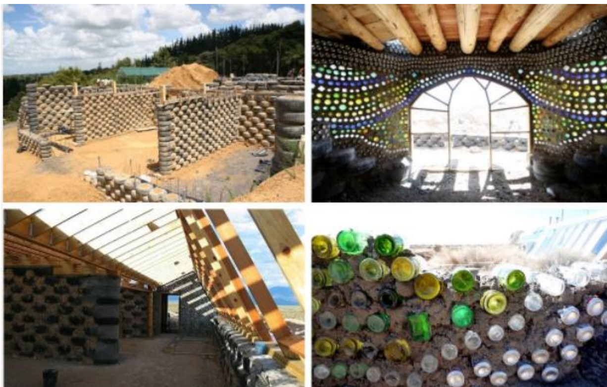
Figure 35 :Différentes étapes de constructIon d'un Earthship
