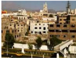
Figure 57 : Renouvellement des batiments
