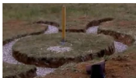
image : 39 l'excavation du terrain
