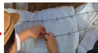
image 42: fixation des sacs avec du fil barbelé
