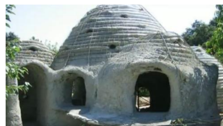
image 44 : recouverte du super-adobe d'un enduit
