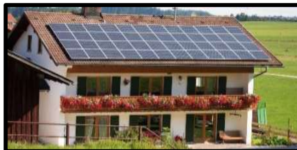
Figure [2.8]: Intégration du panneau solaire/ électrique sur le toit de la maison.
