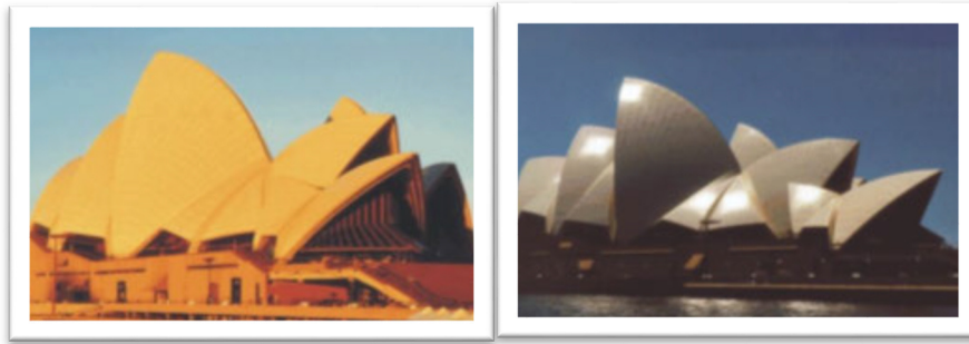
Photos4: de droite à gauche; couleur froide, couleur chaude Source: www.energieplus-lesite.be
