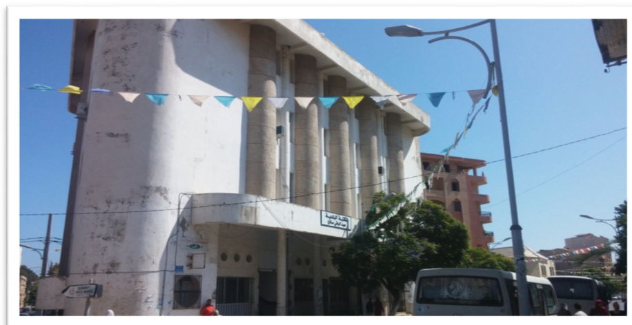
Photo 9 : la façade principale de la bibliothèque municipale
