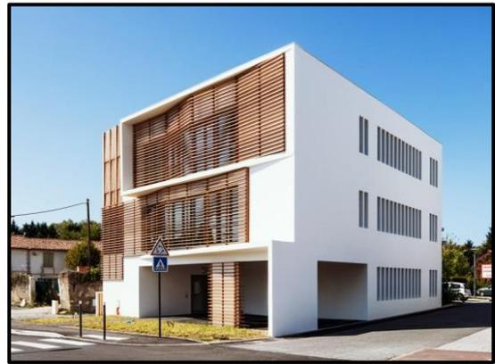
**Figure II.3 :** Protection solaire : brise soleil
