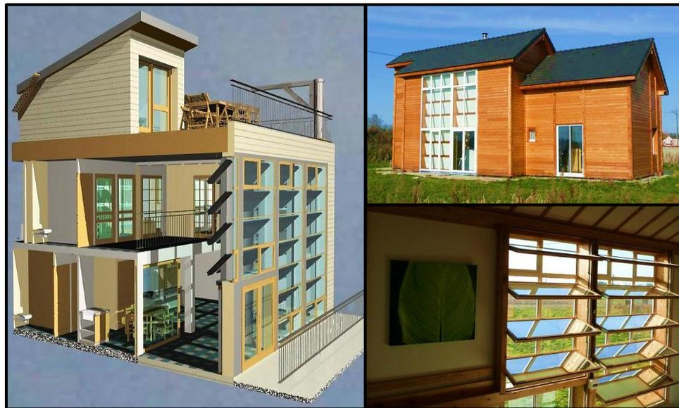
**Figure II.29** : façade intelligente grâce à des brise-soleil automatisés
