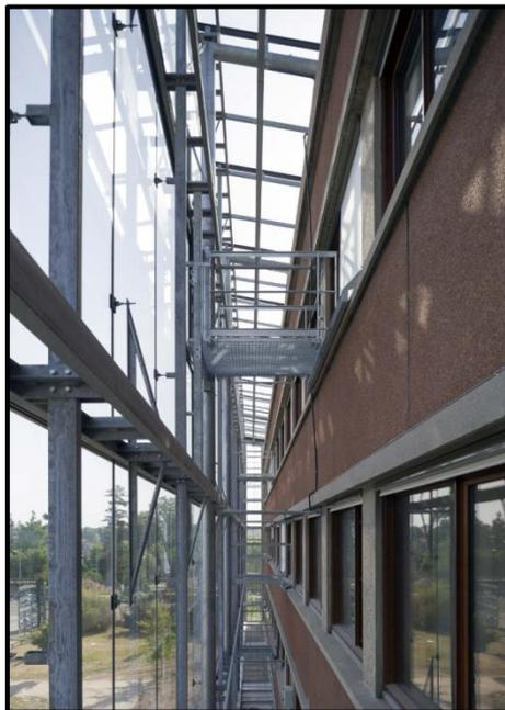
**Figure III.41 :** Vue depuis l'intérieur de la façade Bioclimatique
