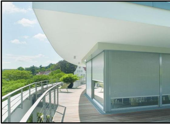
**Figure II.2 :** Protection solaire : volets roulants
