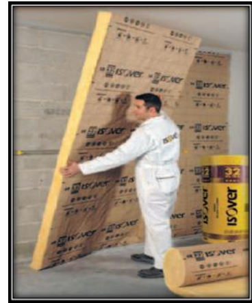
Figure 3.32 : Mise en œuvre d'un isolant par l'intérieur Source : www.isover.fr
