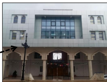
Photo 4.12 : lycée MAKHLOUF Hessnaoui
