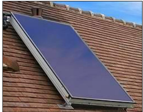
Photo 3.10 : panneau solaire photovoltaïque Source : http://www.ddmagazine.com/1702-Le-chauffe-eau-solaire-le-plus-ecologique.html
