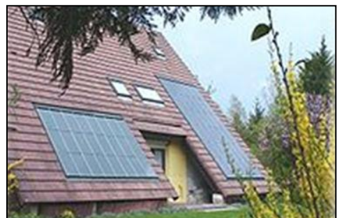
Photo 3.8 : Capteur solaire thermique à gauche et capteur solaire photovoltaïque à droite. Source : Google image
