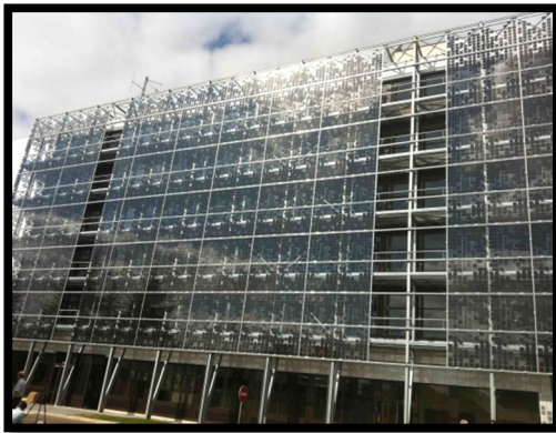
Image n°26 : exemple d'une façade double peau photovoltaïque,
