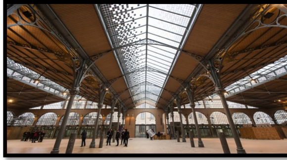
Image n°19 : l'exemple de la verrière photovoltaïque (carreau de temple),
