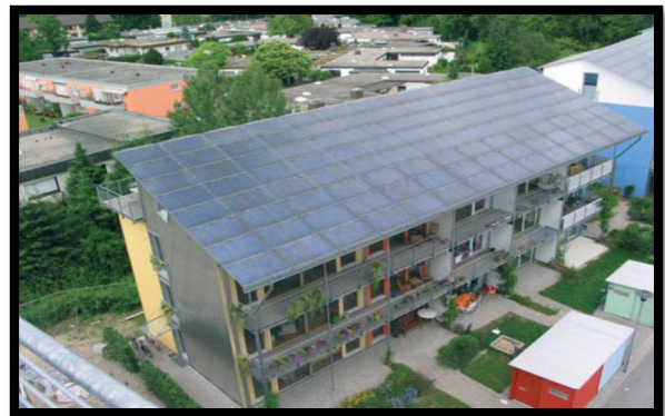
Image n°15: Photovoltaïque dans une habitation collective à Fribourg (Allemagne)
