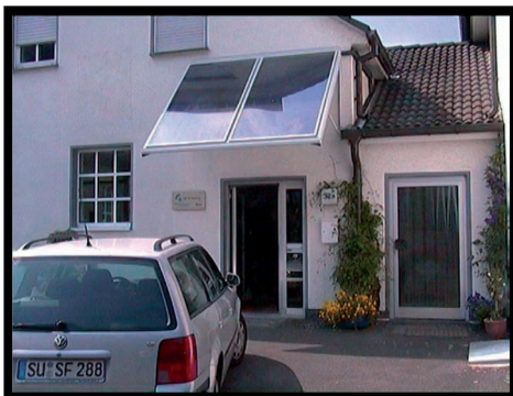
Image n°21 : l'exemple d'un capteur solaire constitué un auvent sur l'entrée.
