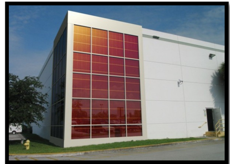
Image n°24: capteurs solaires sur les murs.
