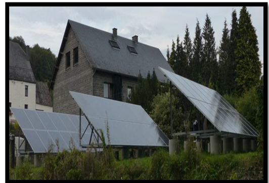
Image n°29: exemple d'installation des capteurs solaires sur une dépendance.
