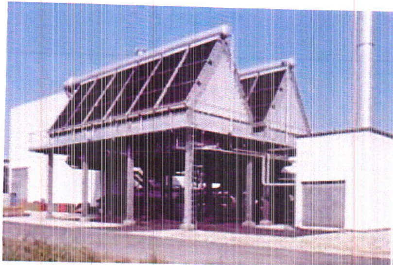
Figure I.4 : Exemple d'un condenseur à air pour la condensation des fumées d'échappement d'une turbine
