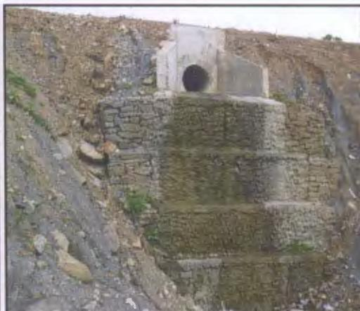
**Photo 2.2** : Gabionnage aval avec exutoire
