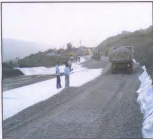
**Photo 2.3** : Traitement au géotextile
