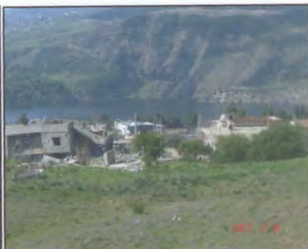
Photo.IV.3 : illustrant le basculement et la ruine de constructions situées au dessous de la RN 27. (H.Zebouchi 2007).
