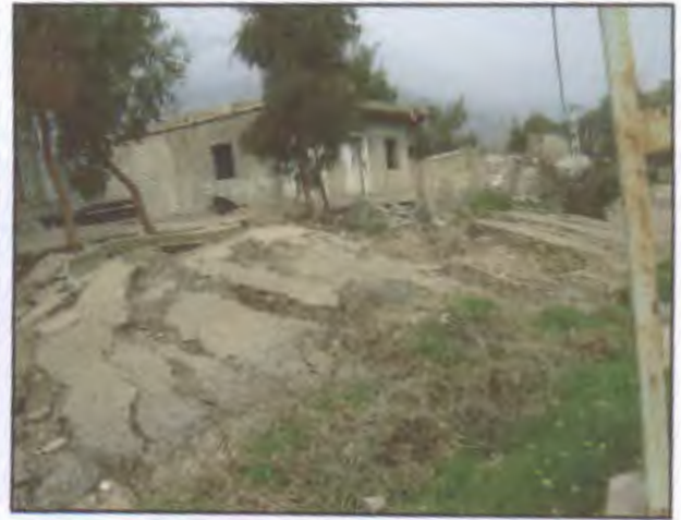
Photo.IV.5 : illustrant un basculement de constructions accompagné par inclinaison de certains arbres. (H.Zebouchi 2007).
