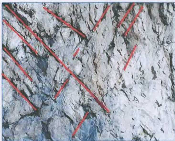
Figure II.9. Falaise carbonatée fortement découpée par fracturation tectonique.
