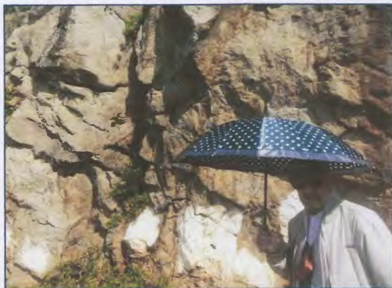
Figure II.7. Massif rocheux dolomitique à structure chaotique Présence de méga fractures ouvertes.
