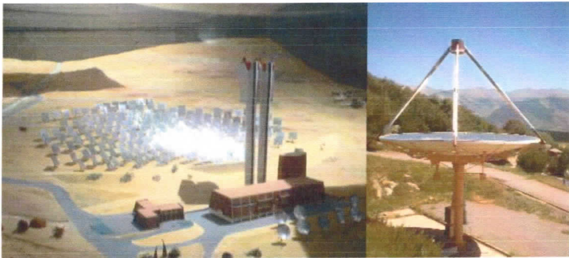
Figure I.19: champ d'héliostat -centrale solaire Thémis France.
