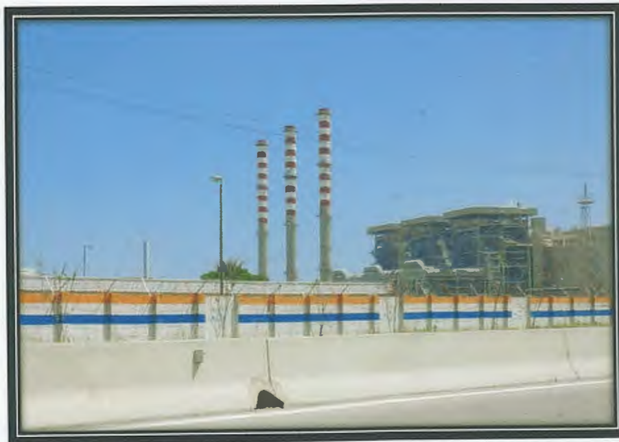
Photo 24 : La centrale électrique d'Achouat dans la commune de Taher.
