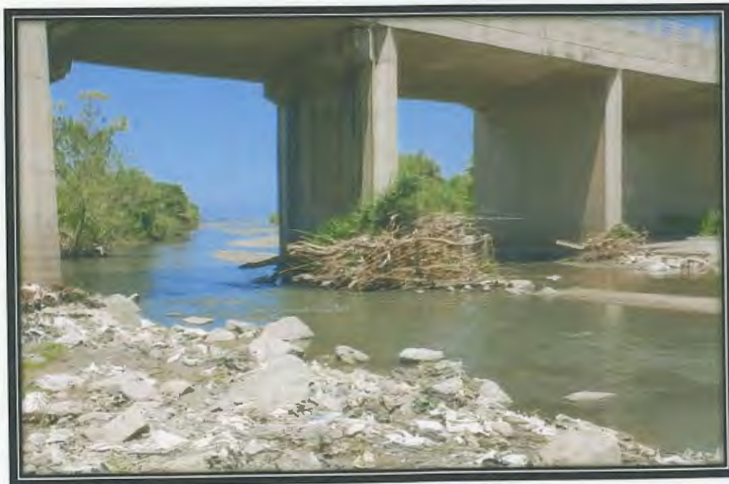
Photo 23 : Pollution par les eaux usées et les déchets ménagers à Oued Nil.
